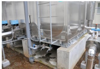
（学校の給水槽に設置された蛇口）
